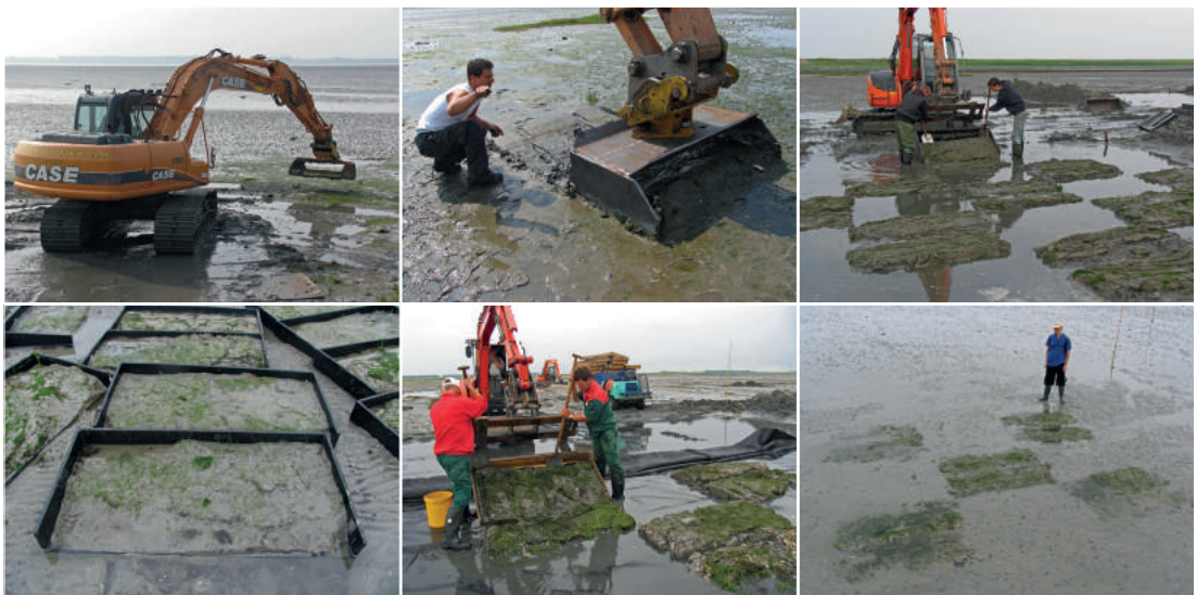
Cadre 16. Photographie de la méthode de relocalisation du gazon sur les sites intertidaux de l'Escaut oriental, montrant la technique modifiée de raclage à la pelle mécanique et le déplacement du transplant.
