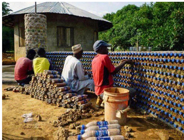
Figure 12 : construction d'une maison en Afrique à partir de bouteille plastiques
