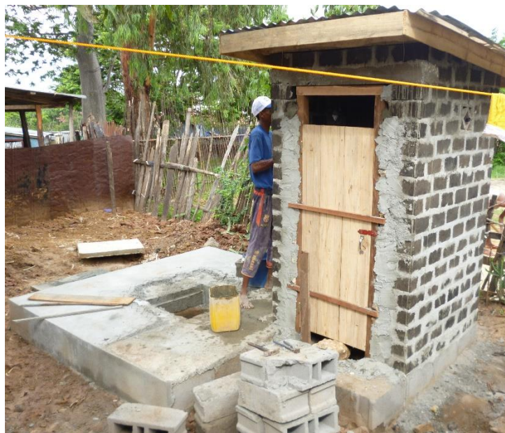
Figure 11 Latrine construite à partir des briques de Madacompost (Source : www.madacompost.com )
