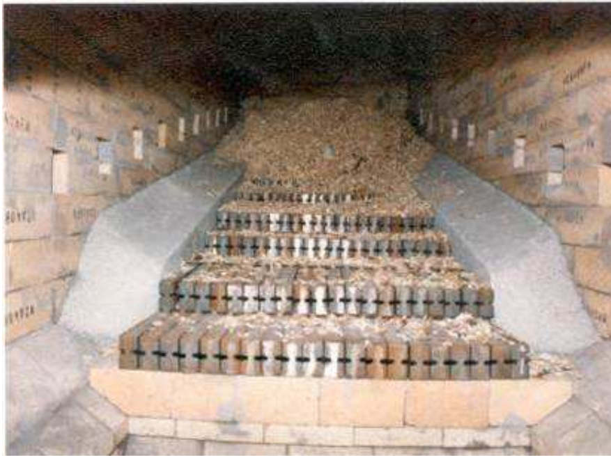
Figure 34 : Exemple de foyer à grille
