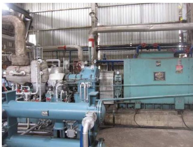
Figure 36: Exemple de turbine à vapeur (Casuco, Vietnam)
