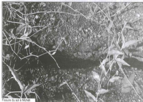
Fissure du sol à Mohéli
